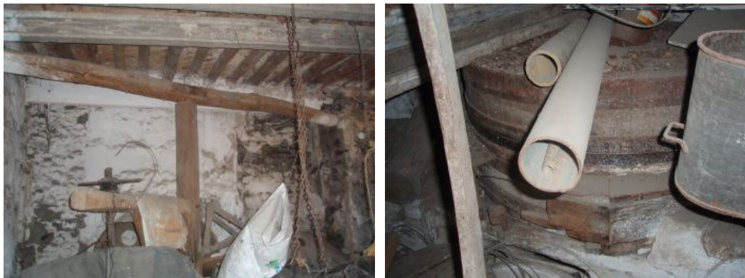
Estado actual de la sala de molienda y de las piedras de moler o empiedro
