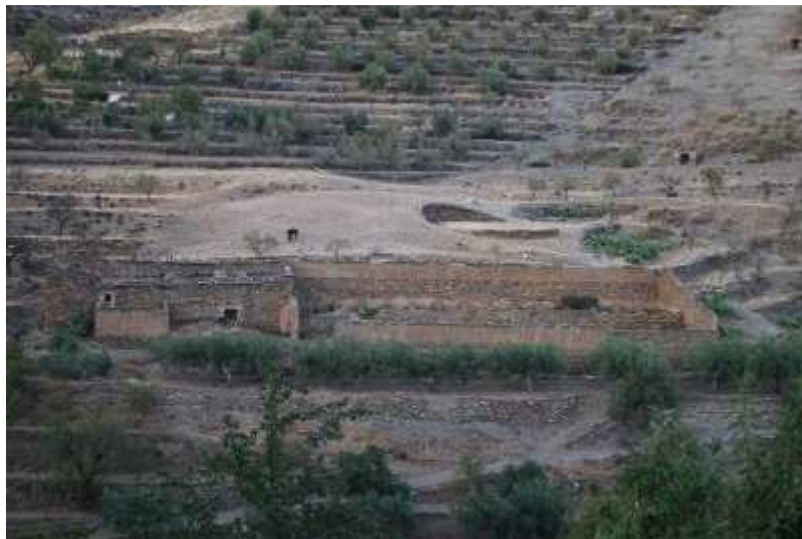
Estado actual de la Almazara de Aulago
